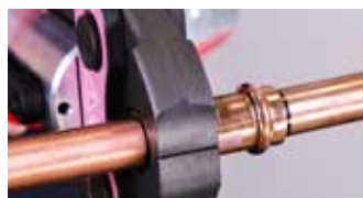
2. Effectuez le sertissage à l'aide de l'outil approuvé. Ne sertir qu'une seule fois
