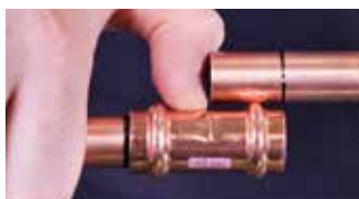
7B. Vérifiez la marque de profondeur
