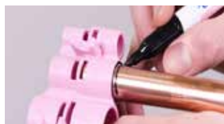
7A. Repérez la profondeur d'insertion sur le tube à l'aide d'une jauge de profondeur
