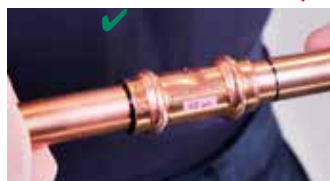
8. Insérez complètement le tube dans le raccord. Assurez-vous que le tube soit complètement inséré avant sertissage
